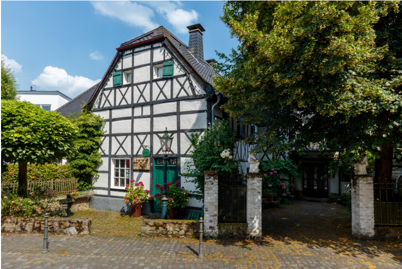
Ansicht des Kückeshauses in Hilden von der Schwanenstraße aus gesehen (2024). Erkennbar sind das Krüppelwalmdach über dem straßenseitigen Giebel und die umlaufenden Andreaskreuze in den Gefachen. Fotograf/Urheber: Rainer Hotz
