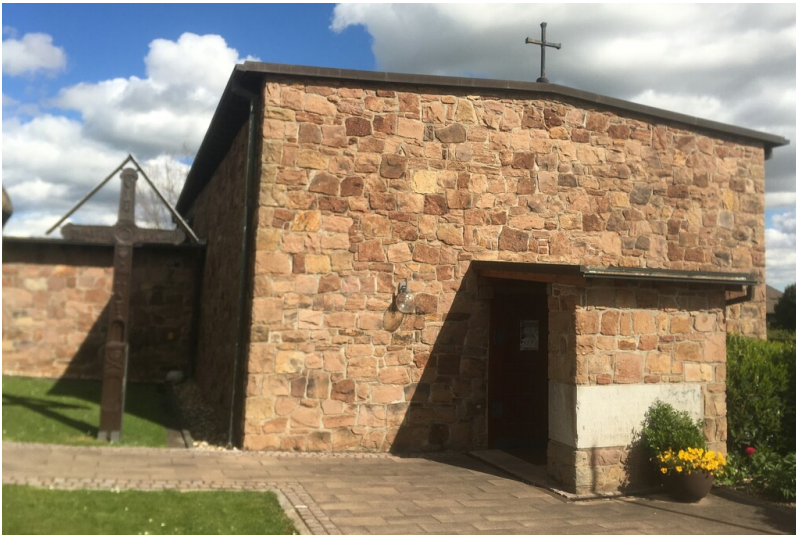
Die Kirche St. Albertus Magnus in Kreuzau-Leversbach (2024), Ansicht von Süden. Fotograf/Urheber: Philipp Müller
