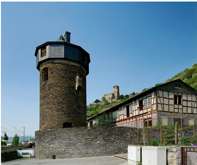
Der Dicke Turm in Kaub (2018) Fotograf/Urheber: Rolf Kranz
