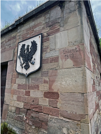
Deutsches Tor mit Kasematten in Saarlouis (2024) Fotograf/Urheber: Karl Peter Wiemer
