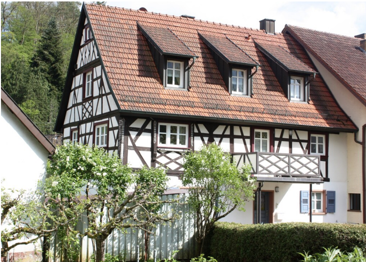
Fachwerkhaus Hauptstraße 24 in Niederschlettenbach Fotograf/Urheber: Albert Nagel
