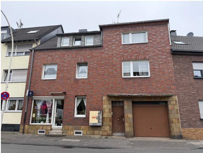
Wohn- und Geschäftshaus in der Breite Straße mit Baukeramikelementen (2025) Fotograf/Urheber: Nicole Schmitz
