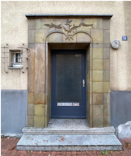
Doppelwohnhaus mit Baukeramik der Köln-Frechener Keramik (Ooms) (2024) Fotograf/Urheber: Nicole Schmitz
