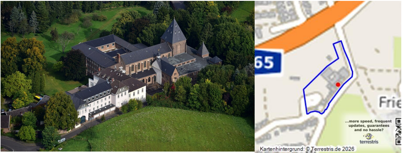
Luftaufnahme des Klosters Maria Hilf in Bonn-Endenich (2017). Fotograf/Urheber: Wolkenkratzer
