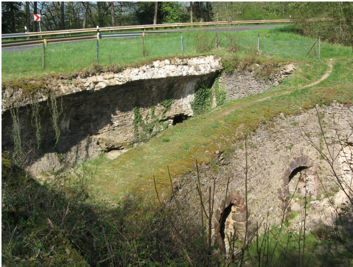
Flankenbatterie der Festungsrue Mont-Royal (2024) Fotograf/Urheber: Sammlung Lutz Reichardt
