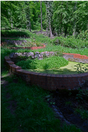
Schankenbrunnen in Saarbrücken (2024) Fotograf/Urheber: Karl Peter Wiemer
