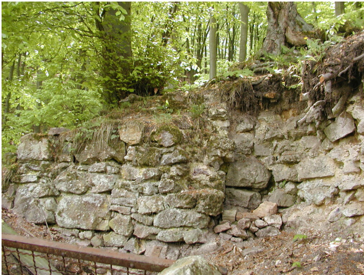
Turmrest im Westen der Anlage (2006) Fotograf/Urheber: Dieter Barz
