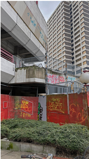
Ihme-Zentrum Hannover (2023) Fotograf/Urheber: Karl Peter Wiemer
