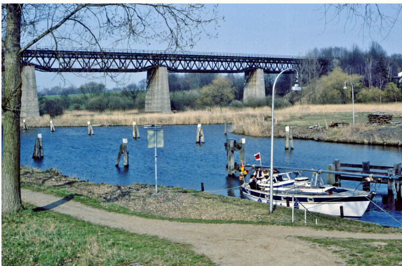
Eisenbahnbrücke bei Berkenthin (1984) Fotograf/Urheber: Wolfgang Bügel
