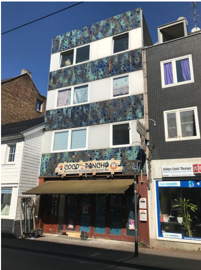
Wohn- und Geschäftshaus mit grün-blau-grauer KerAion-Fassade in Frechen (2020) Fotograf/Urheber: Nicole Schmitz
