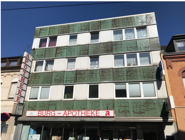
Die Fassade des Wohn- und Geschäftshauses wird gegliedert durch Fensterreihen und Reihen aus grün-braunen KerAion-Platten (2020) Fotograf/Urheber: Nicole Schmitz
