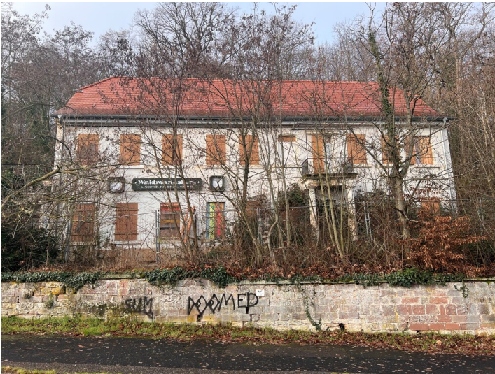
Leerstehende Waldmannsburg (2024) Fotograf/Urheber: Christine Brehm, SGD Süd
