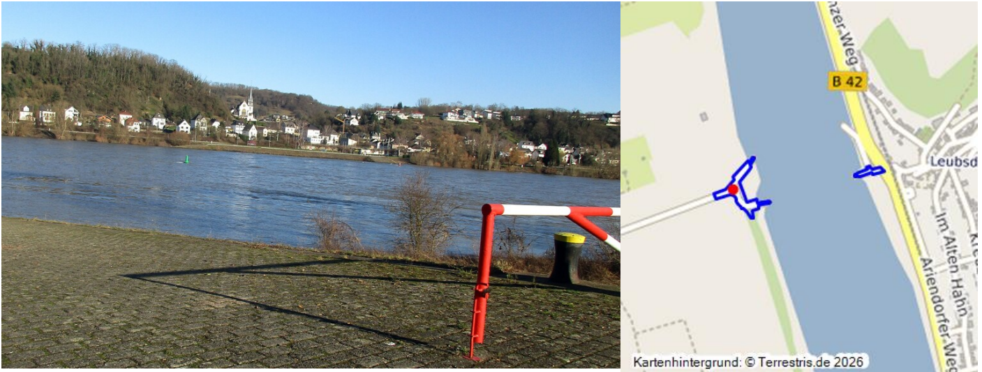
Die Bauten der NATO-Rampe zwischen Sinzig und Leubsdorf (am Rhein) im Wasserschutzgebiet "Goldene Meile" südlich von Remagen bei Sinzig (2025). Auf der anderen Seite des Rheins der Ort Leubsdorf. Fotograf/Urheber: Franz-Josef Knöchel
