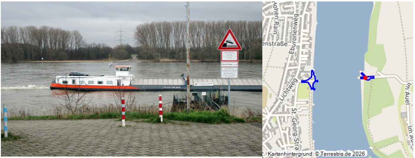
Blick von Widdig aus auf die Zufahrt an der Rheidter Uferseite mit der Ersatzübergangsstelle über den Rhein (so genannte "NATO-Rampe") zwischen Bornheim-Widdig und Niederkassel-Rheidt (2024). Fotograf/Urheber: Franz-Josef Knöchel
