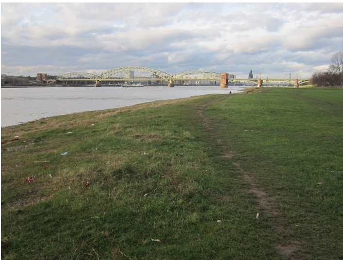
Die Kölner Südbrücke von Süden und der Bereich der Poller Wiesen bzw. Poller Köpfe (2014) Fotograf/Urheber: Claus Weber
