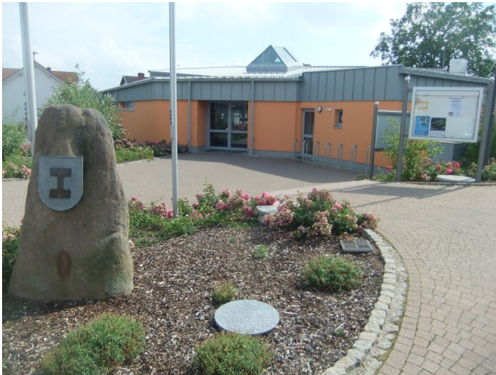
Dorfgemeinschaftshaus in Bornheim (2017) Fotograf/Urheber: Gemeinde Bornheim
