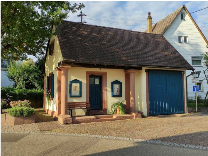
Wachthäusel der Gemeinde Bornheim (2024) Fotograf/Urheber: Gemeinde Bornheim
