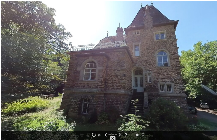
Virtuelle 360-Grad-Ansicht der Fabrikantenvilla Haan in Moselkern (2023) Fotograf/Urheber: Felix Schlieff; Tamina Hommer
