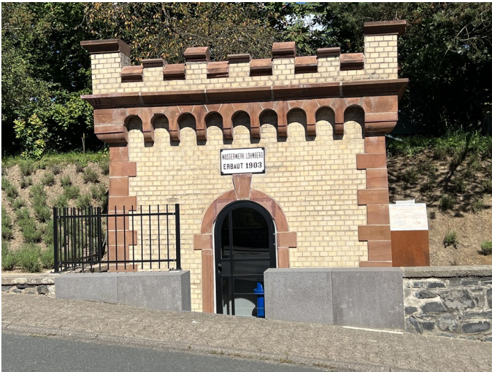
Wasserhochbehälter in Löhnberg (2023) Fotograf/Urheber: Heike Lachnit
