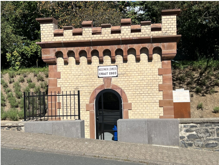
Wasserhochbehälter in Löhnberg (2023) Fotograf/Urheber: Heike Lachnit
