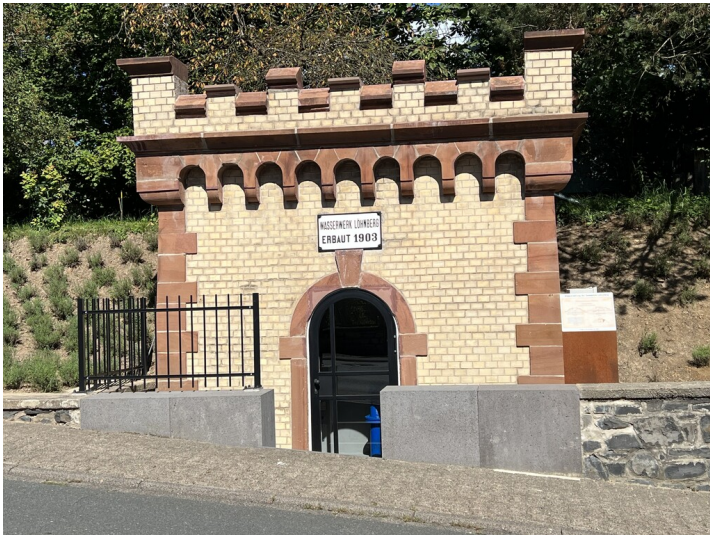
Wasserhochbehälter in Löhnberg (2023) Fotograf/Urheber: Heike Lachnit
