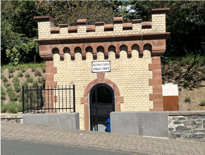
Wasserhochbehälter in Löhnberg (2023) Fotograf/Urheber: Heike Lachnit
