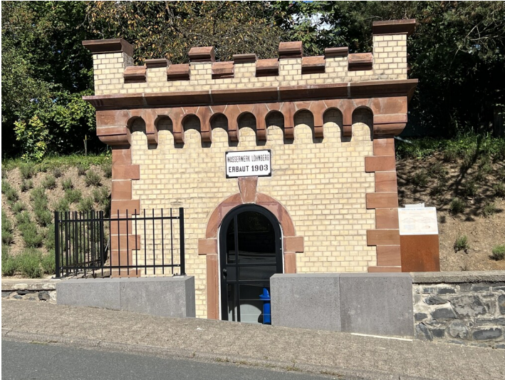
Wasserhochbehälter in Löhnberg (2023) Fotograf/Urheber: Heike Lachnit
