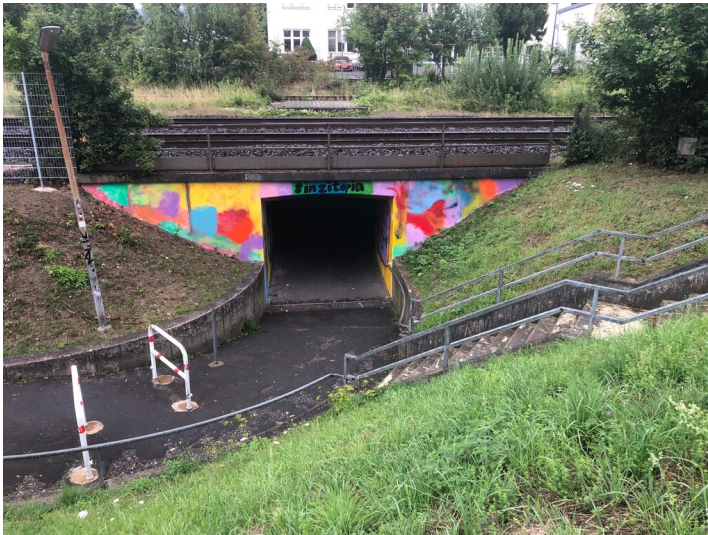
Fußgängerunterführung südlich des Sinziger Bahnhofs (2023) Fotograf/Urheber: Elmar Knieps
