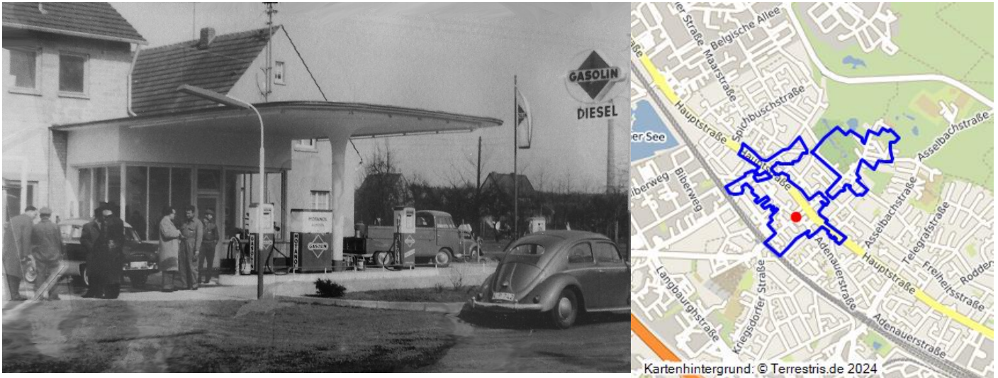
Historische Aufnahme der Gasolin-Tankstelle in Troisdorf-Spich aus den 1950er-Jahren, davor rechts ein Volkswagen-PKW Typ 1, "Ovali-Käfer". Fotograf/Urheber: unbekannt
