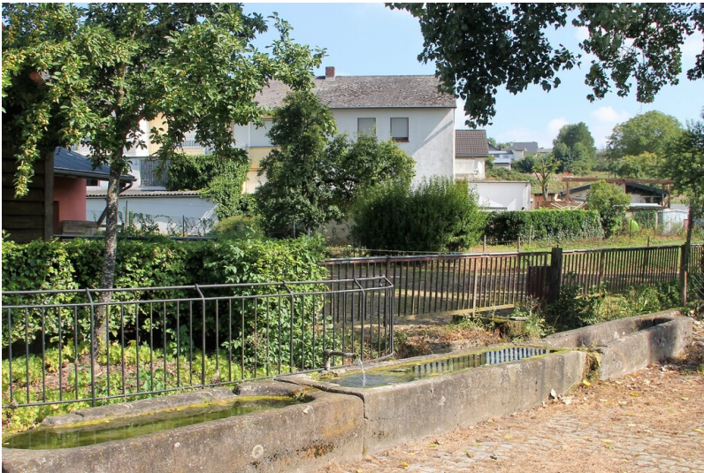
Brandweiher in Metterich (2024) Fotograf/Urheber: Ortsgemeinde Metterich
