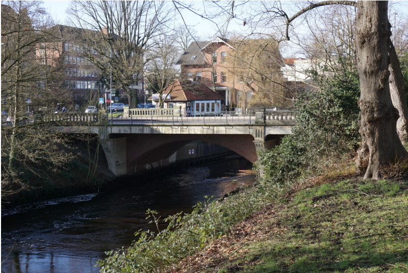
Stade, Hohentorsbrücke, Bahnhofstraße (2024) Fotograf/Urheber: Claus Weber
