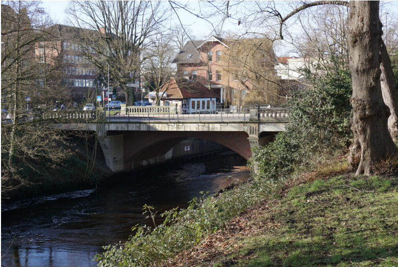
Stade, Hohentorsbrücke, Bahnhofstraße (2024) Fotograf/Urheber: Claus Weber
