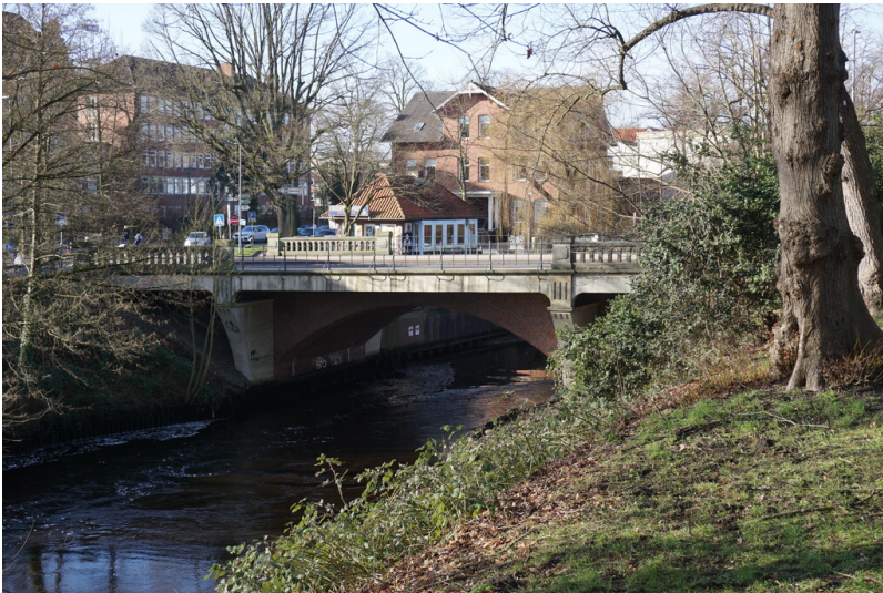
Stade, Hohentorsbrücke, Bahnhofstraße (2024) Fotograf/Urheber: Claus Weber
