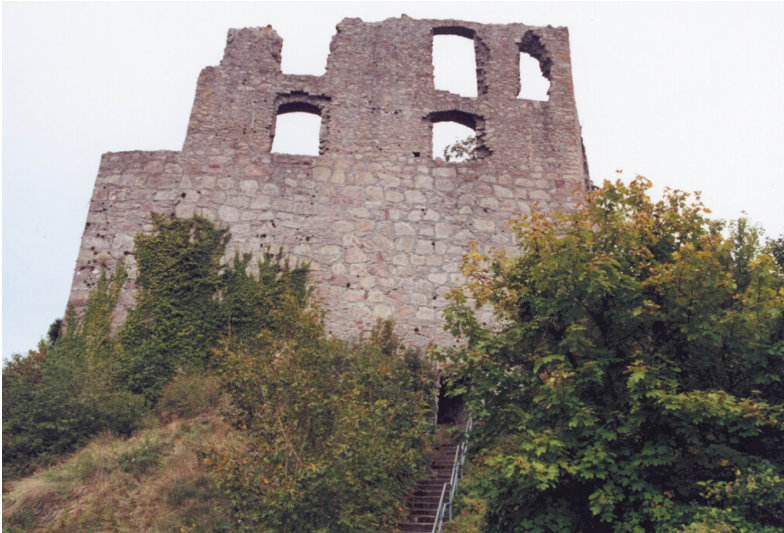
Westseite des Wohnbaus Fotograf/Urheber: Jens Stöcker
