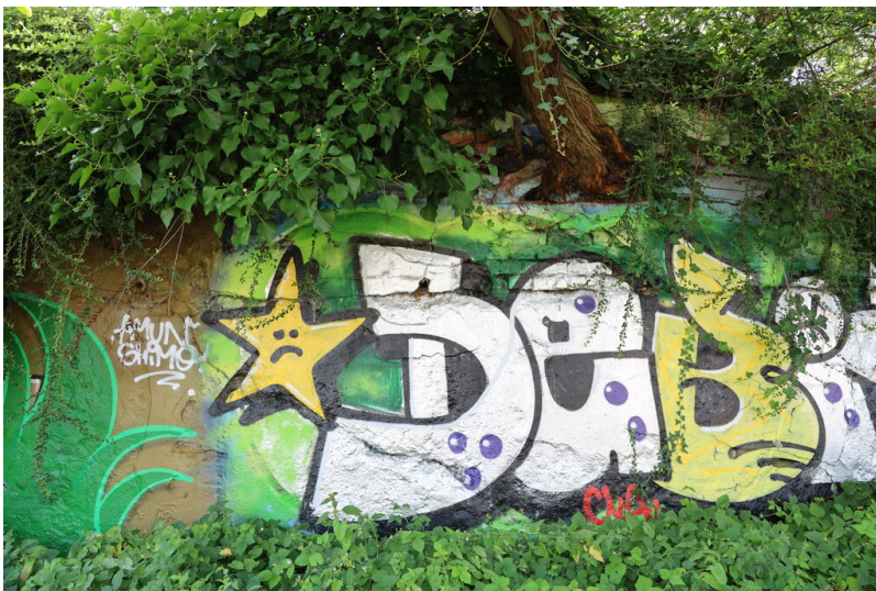
Grundstücksmauer der Steinzeugfabrik Grosspeter-Lindemann in Richtung Bahnhof Königsdorf (2024) Fotograf/Urheber: Nicole Schmitz
