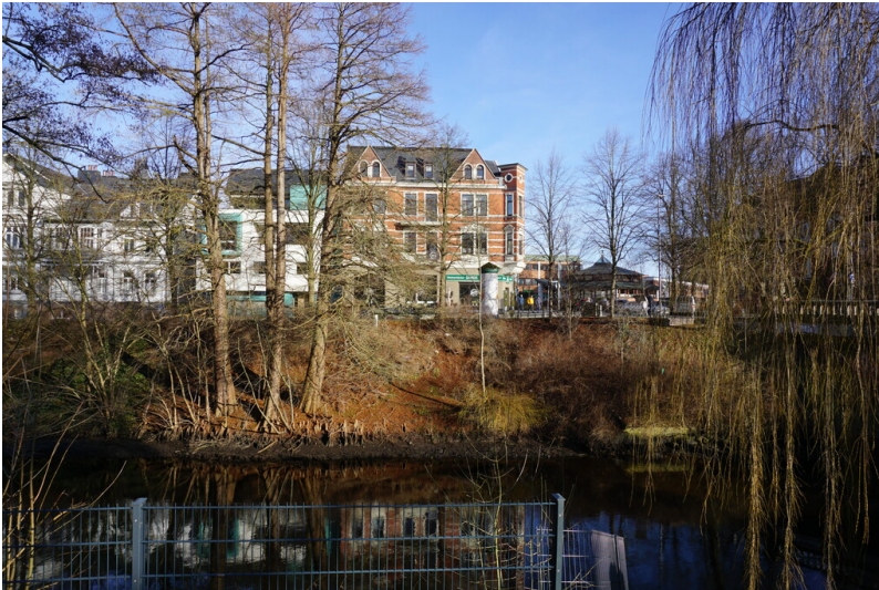
Stade, Standort des ehemaligen Hohen Tores, Blick vom ehemaligen Hohentorsravelin (2024) Fotograf/Urheber: Claus Weber
