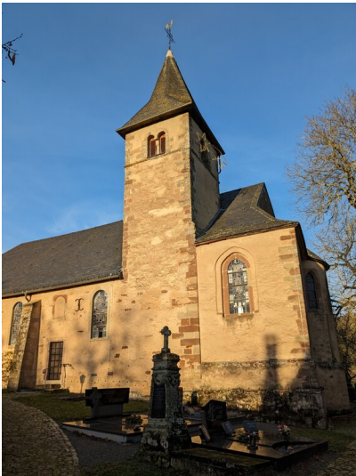
Katholische Filialkirche St. Peter in Roth an der Our (2023) Fotograf/Urheber: Katarina Gerlach, Bitburg
