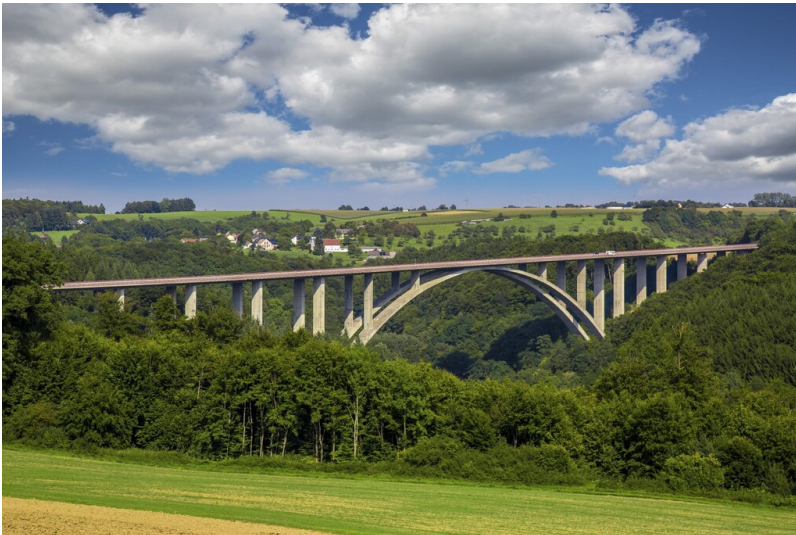
Kylltalbrücke (A60) zwischen Fließem und Wilsecker (2023) Fotograf/Urheber: Ortsgemeinde Fließem
