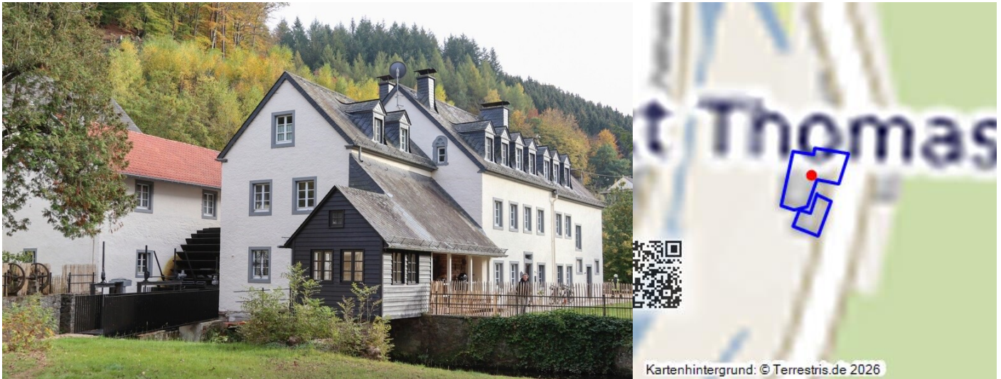
Ehemalige Klostermühle in Sankt Thomas (2023) Fotograf/Urheber: Ortsgemeinde St. Thomas
