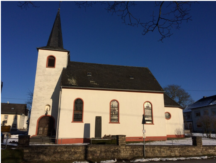
Filialkirche St. Brictius in Oberstedem (2023) Fotograf/Urheber: Ortsgemeinde Oberstedem
