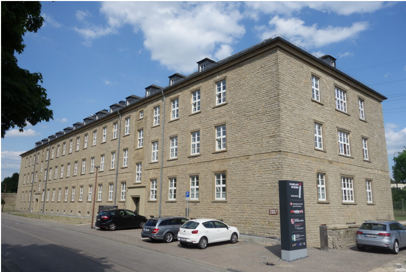
Alte Kaserne in Bitburg (2023) Fotograf/Urheber: Detlef Kleintitschen, Kreisdenkmalpfleger des Eifelkreises
