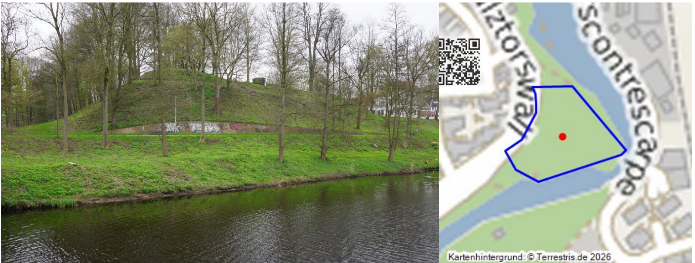
Stade (2023). Güldensternbastion, Bastionsspitze und Ostflanke Fotograf/Urheber: Claus Weber
