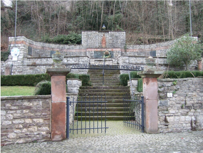
"Blankenheimer Ehrenmal", Gesamtansicht (2023) Fotograf/Urheber: Markus M. Schmitz
