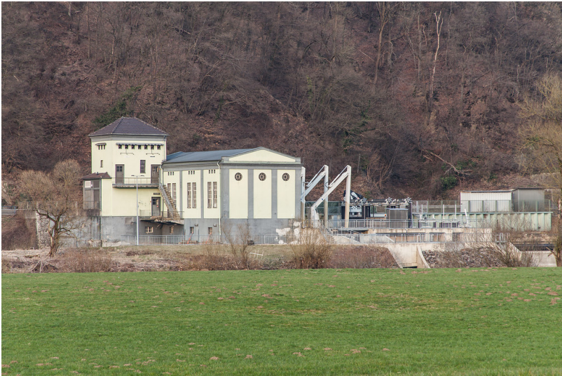
Windeck-Stromberg, Sieg-Wasserkraftwerk Unkelmühle (2015) Fotograf/Urheber: Silvia Margrit Wolf
