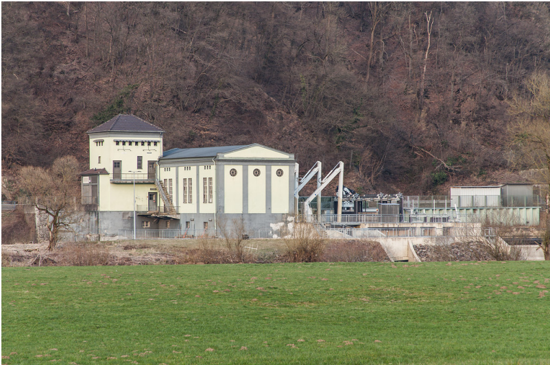
Windeck-Stromberg, Sieg-Wasserkraftwerk Unkelmühle (2015) Fotograf/Urheber: Silvia Margrit Wolf
