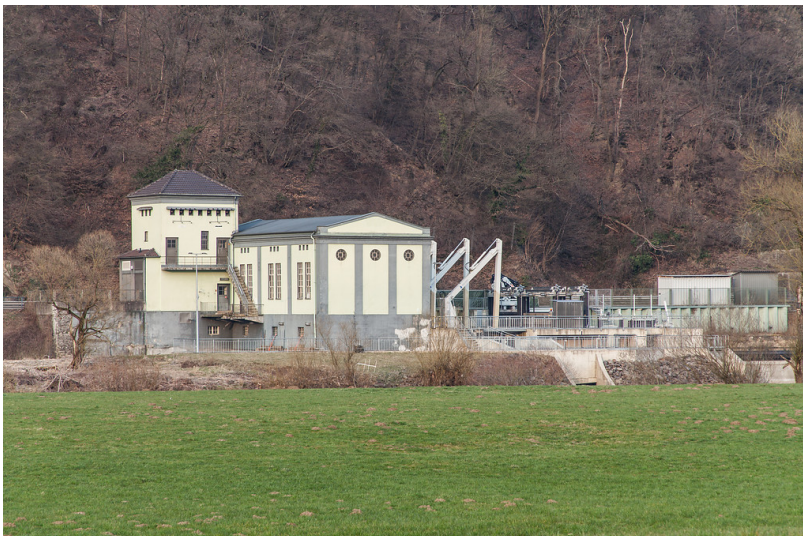
Windeck-Stromberg, Sieg-Wasserkraftwerk Unkelmühle (2015) Fotograf/Urheber: Silvia Margrit Wolf
