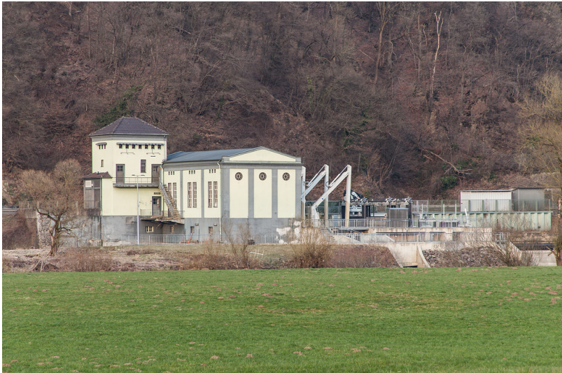
Windeck-Stromberg, Sieg-Wasserkraftwerk Unkelmühle (2015) Fotograf/Urheber: Silvia Margrit Wolf
