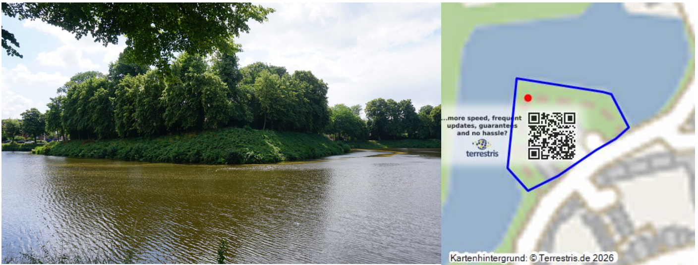
Stade, Wrangelsbastion (2023) Fotograf/Urheber: Claus Weber
