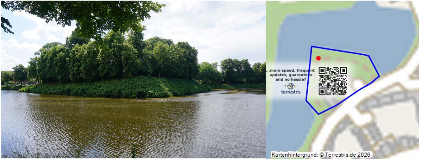
Stade, Wrangelsbastion (2023) Fotograf/Urheber: Claus Weber
