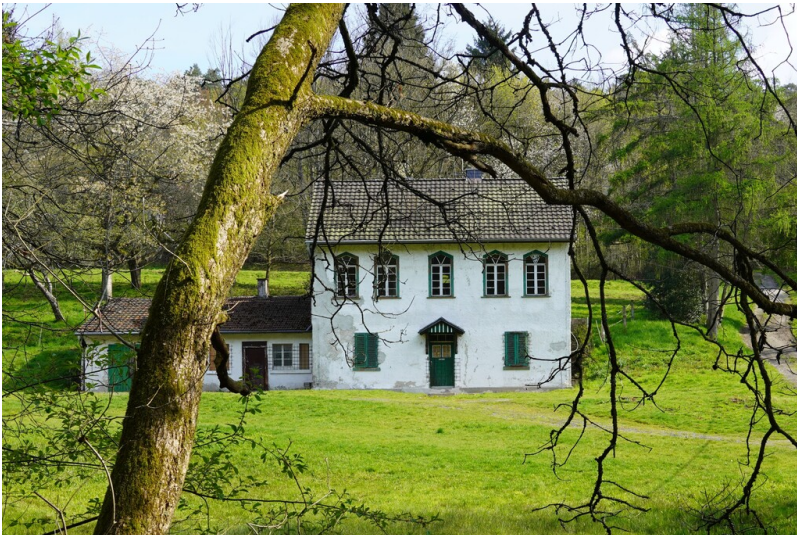
Das ehemalige Zechenhaus der Grube Apfel im Volbachtal (2023). Fotograf/Urheber: Lisa Kröger
