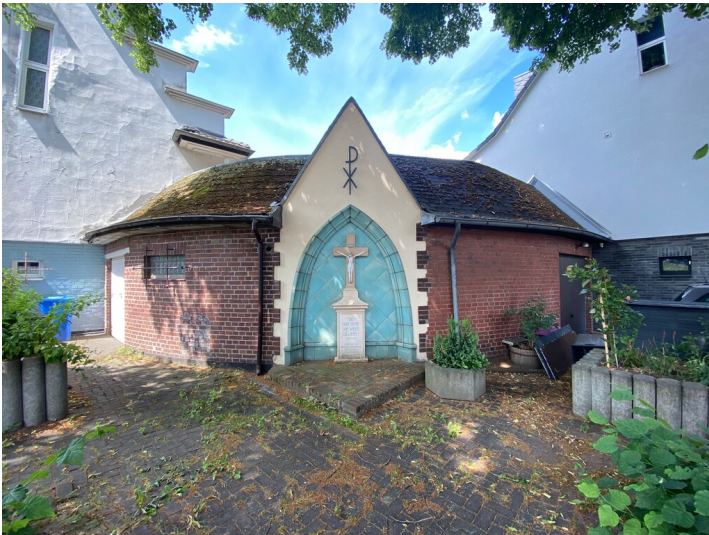
Verbindungstrakt mit Keramiknische und Bildstock in der Ulrichstraße (2024) Fotograf/Urheber: Nicole Schmitz
