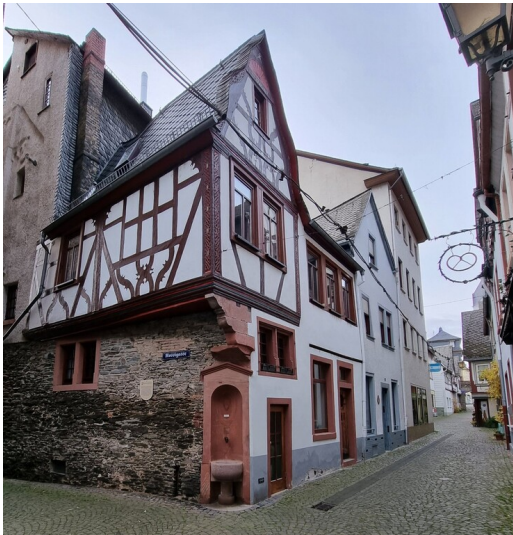
Das Dachschieferbergbau-Museum in der Metzgergasse in Kaub (2023) Fotograf/Urheber: Marion Halt
