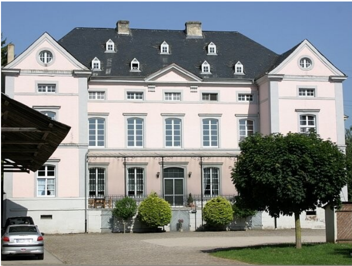
Schlossgut Niedersgegen Fotograf/Urheber: Kreisverwaltung Eifelkreis Bitburg-Prüm, erstellt im Rahmen des Zukunfts-Check Dorf
