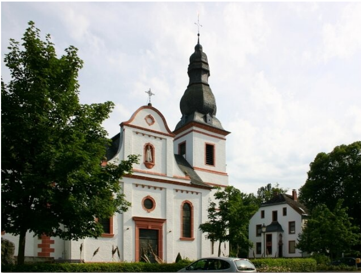
Katholische Pfarrkirche St. Hubertus in Körperich Fotograf/Urheber: Kreisverwaltung Eifelkreis Bitburg-Prüm, erstellt im Rahmen des Zukunfts-Check Dorf
